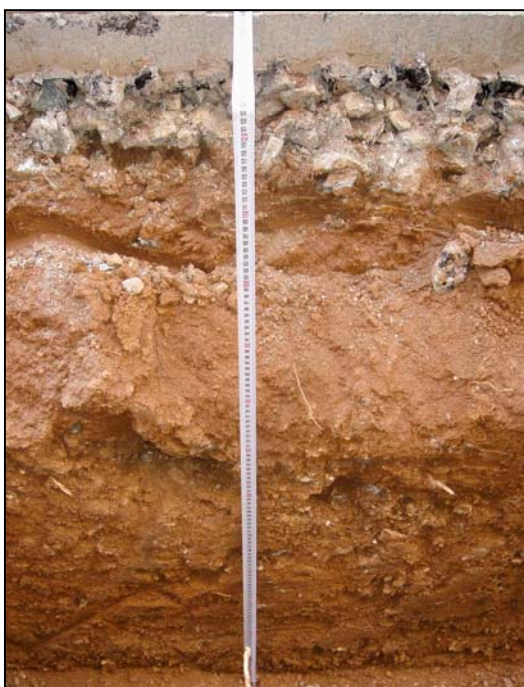
Detall del perfil de la rasa realitzada en el C/Encarnació. En la imatge s'identifica la UE 101 (asfalt) i la UE 102 (farciment)
